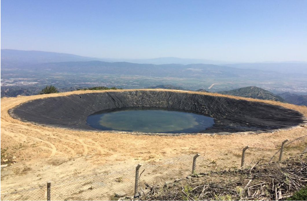
AYDIN ORMAN İŞLETME MÜDÜRLÜĞÜ SU TOPLAMA ÇUKURU
